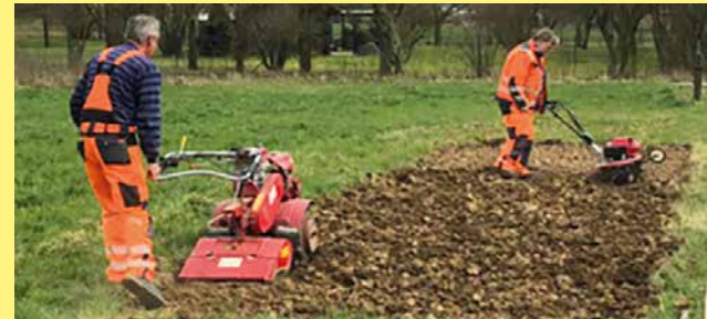
Bodenvorbereitung nach dem Entfernen der Grassoden durch Fräsen
