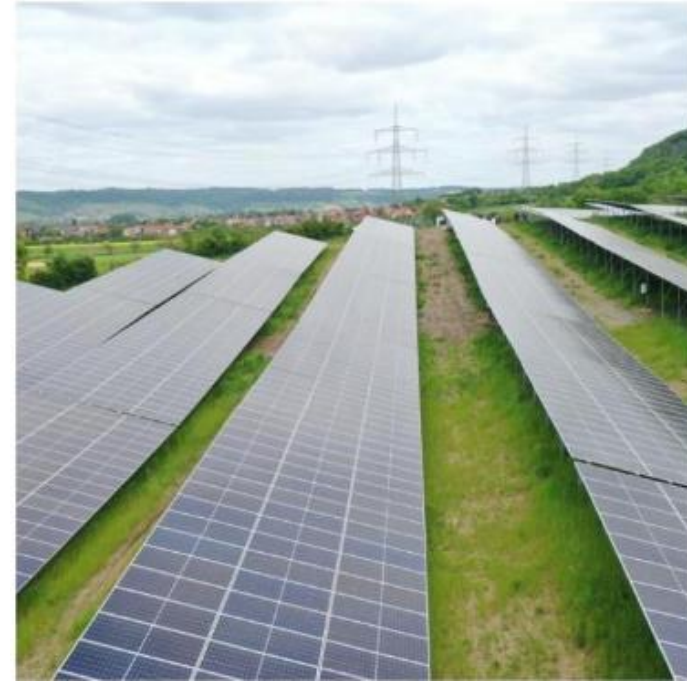
Foto: Freiflächen-PV-Anlage Sand am Main
